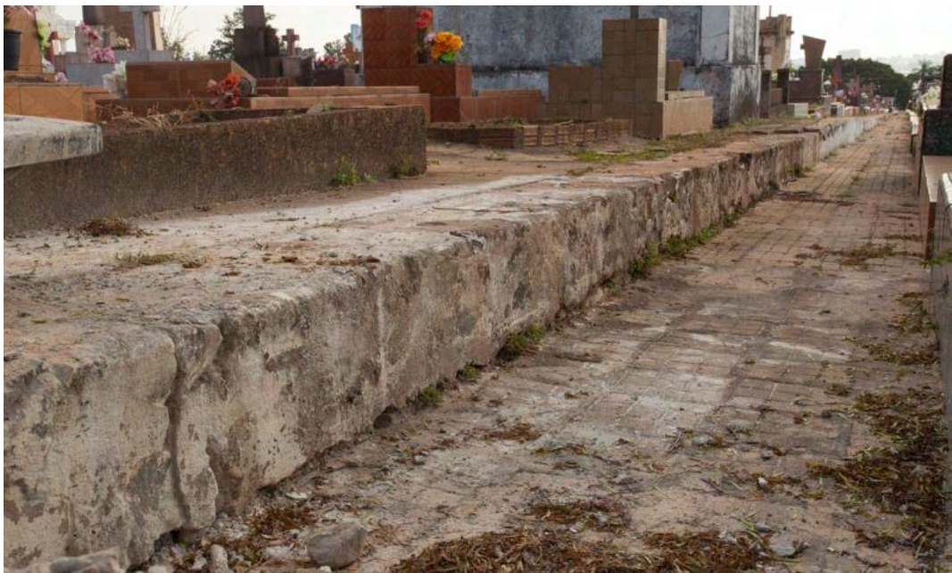
Figura 26. Vestígios próximos ao ossário antigo. Cemitério Nossa Senhora do Carmo, 2016. Fonte: Coleção FPMSC. Fotógrafo Walter Fukuhara.
