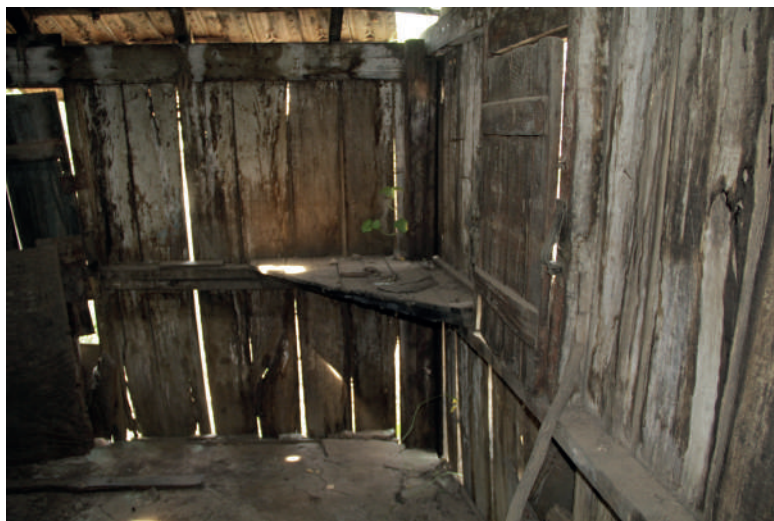
Figura 33: Detalhe do canto onde funcionava a cozinha no Barraco da Gegê. Vila Izabel, São Carlos. 2014.
